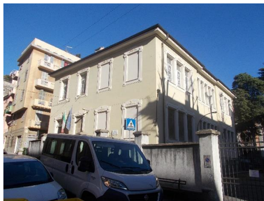
Figura 1.1 - Vista della facciata
