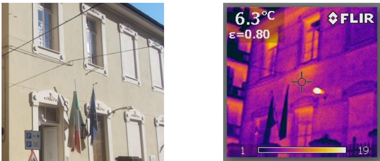
Figura 4.3 – Rilievo termografico della parete
