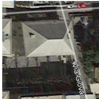
Figura 2.2 - Vista satellitare dell'edificio (Fonte: Google Earth)
